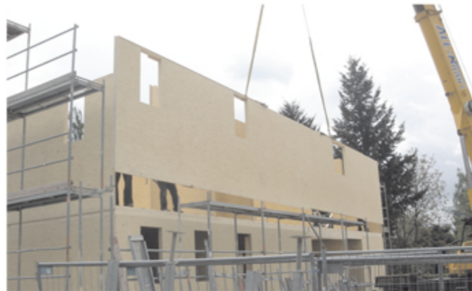
Családi ház építés VIP-integrált OSB-táblaelemekkel
