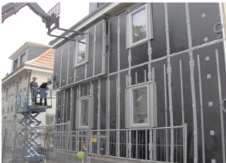
VIP/QASA a nagyelemes hőszigetelő technikában (GEDT), járdával határos homlokzatok felújítása VIP-integrált elemekkel passzívház minőségben
